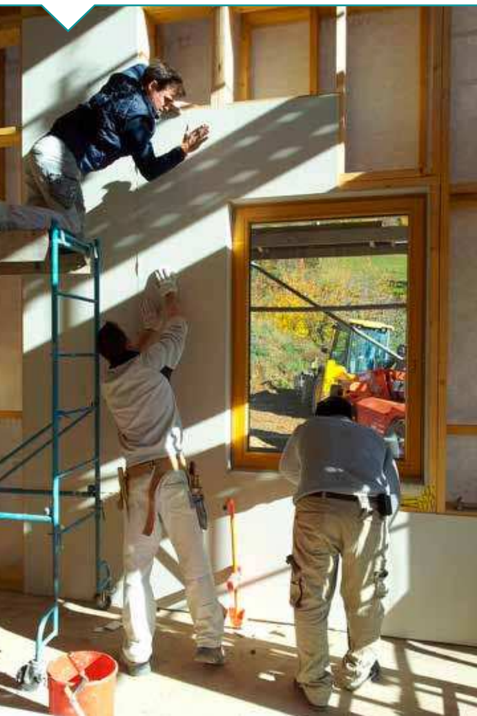
Les panneaux de Fermacell assurent 5 fonctions à eux seuls : parement intérieur, contreventement, frein-vapeur, étanchéité à l'air et apport d'inertie.
