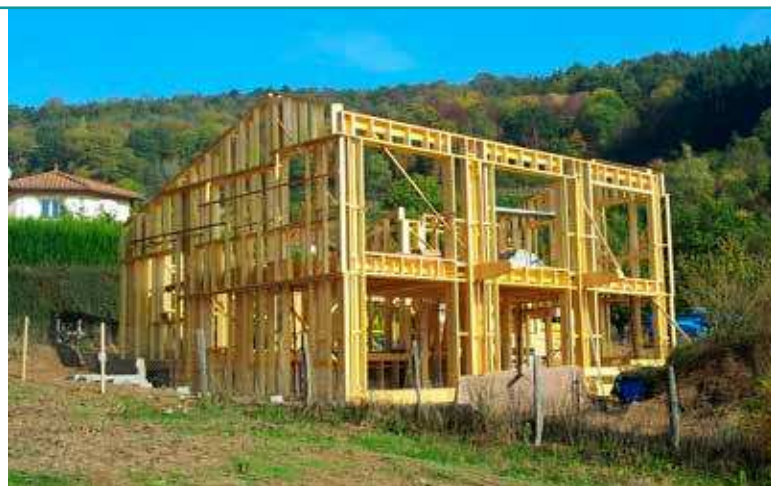
L'ossature double de la maison en pin massif.
